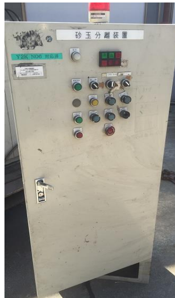
直流電源盤もあり
